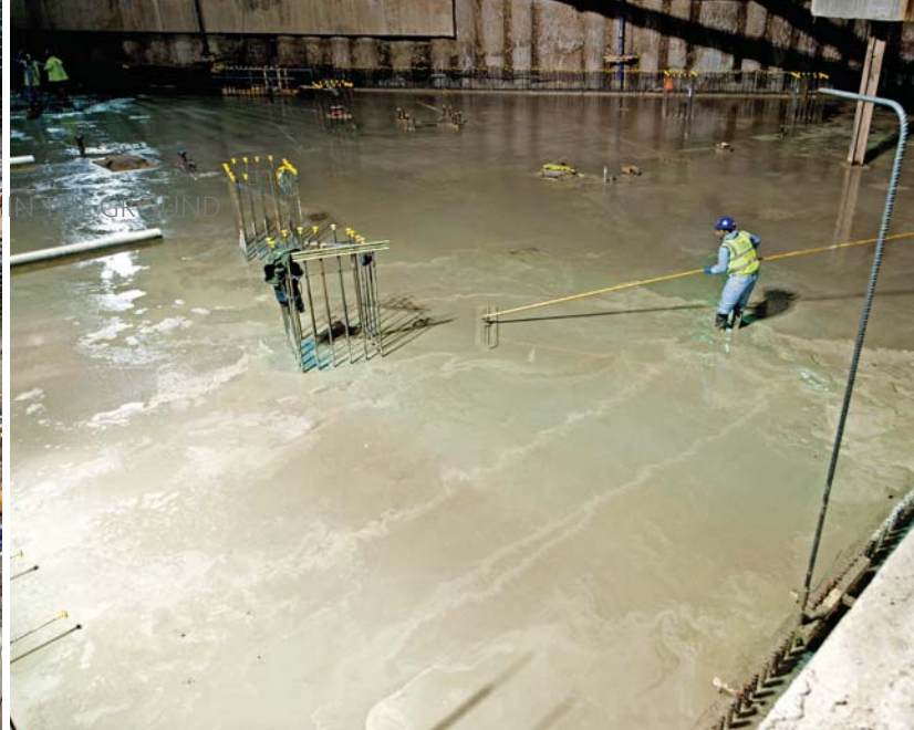
Pour for the B3 slab.
